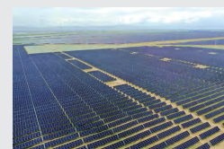
▲2023年9月27日，国家电投黄河公司海南基地共和县100万千瓦光伏发电第二批50万千瓦项目顺利接入昕阳变330千伏汇集站，实现全容量并网发电。
